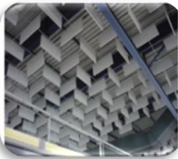
Plafond de local industriel avec baffles
